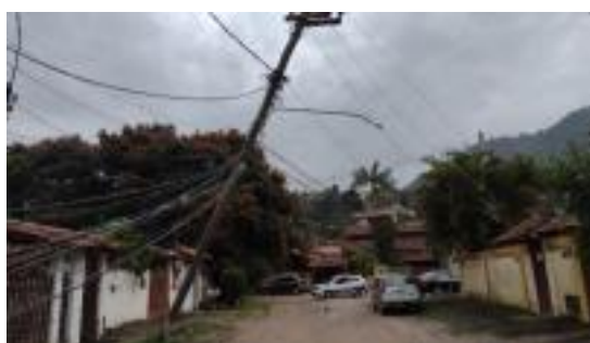
Figura 2. Ilustrando evento de poste caído, mostrando claramente o risco do poste e fiação de alta tensão caírem em cima de carros ou até mesmo de pessoas que passavam pelo local.
