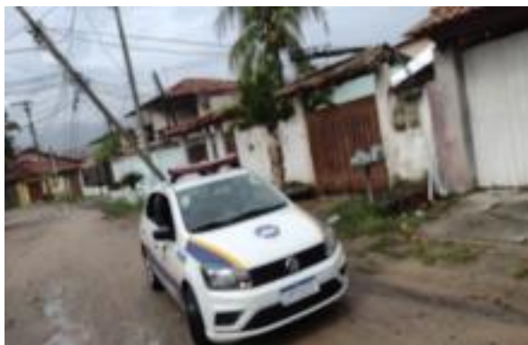
Figura 1. Ilustrando evento de poste caído, causando risco iminente aos moradores da região.
